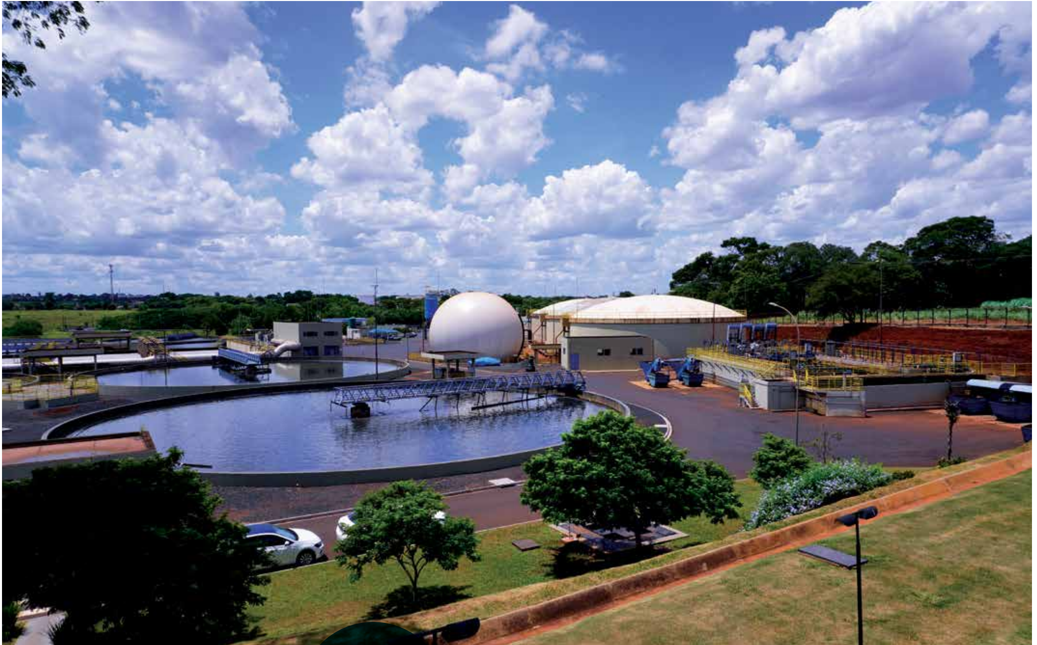
GS Inima AMBIENT - WWTP Ribeiro Preto
