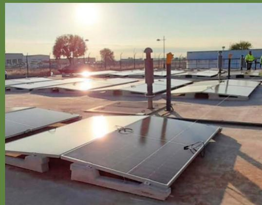
El objetivo de este proyecto es reducir el consumo energético y la huella de carbono del proceso de depuración de las aguas residuales de los vecinos de la Urbanización El Quiñón mediante la instalación de paneles fotovoltaicos. El ahorro anual previsto oscilará entre el 15% y el 20% del consumo energético de la EDAR.
